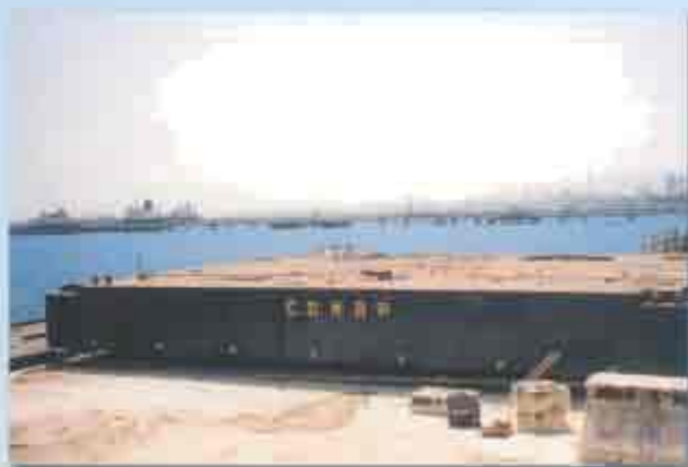
Pontone Comap - M - mentre scivola sulle skid spinto da due verricelli
