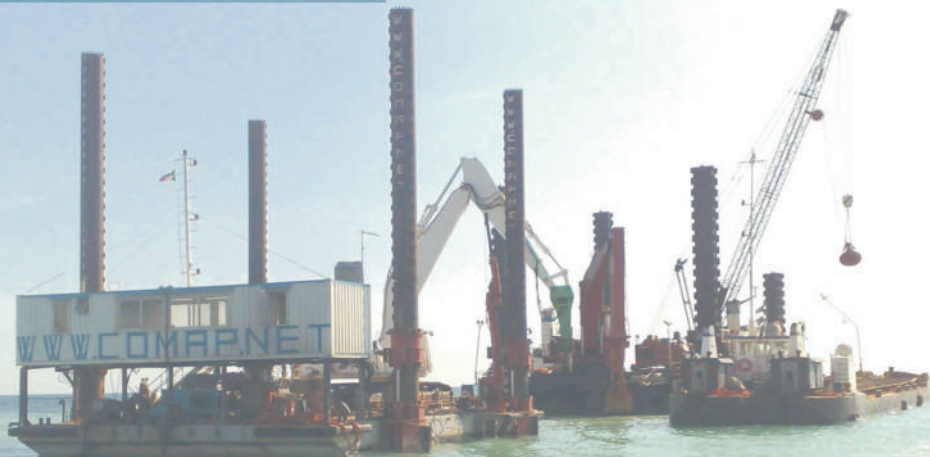
Dragaggio roccia Enel Torrevaldalica Civitavecchia
