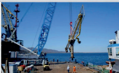
SOST. BRACCI "BARETTI" 45 TON, CON BR. "FLEXA". I1 SARLUX
