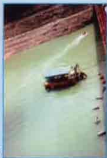
5-8) Il pontone in esercizio con il tangondotto sostenuto da galleggianti. 5-8) Pontoon in working phase with mud conduit supported by buoys.
