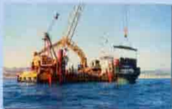
Nato e posizionamento in opera della camera di aspirazione
