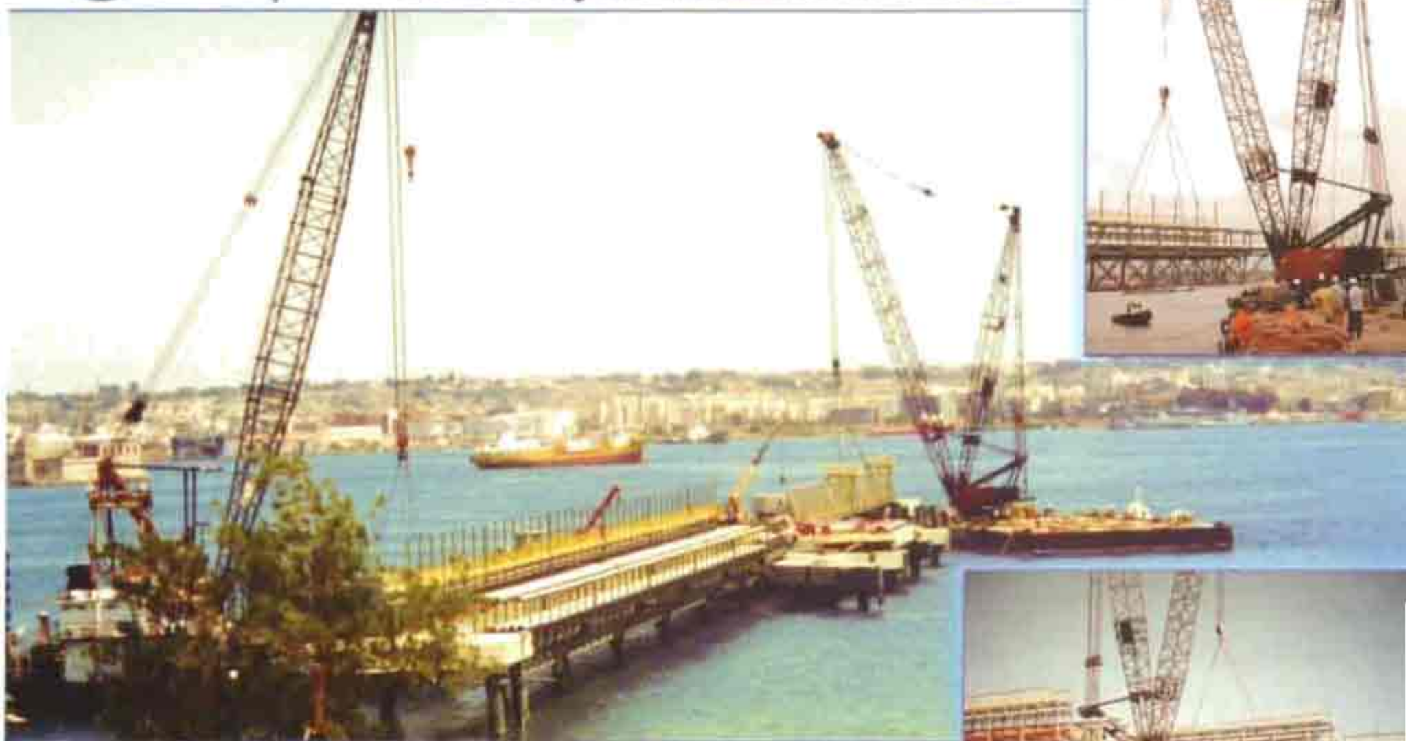
MONTAGGIO PONTILE SASOL AUGUSTA 2001
