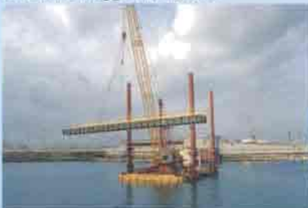
Montaggio travi composte 250x800xSp.20x12 in Acciaio Corten "B".
