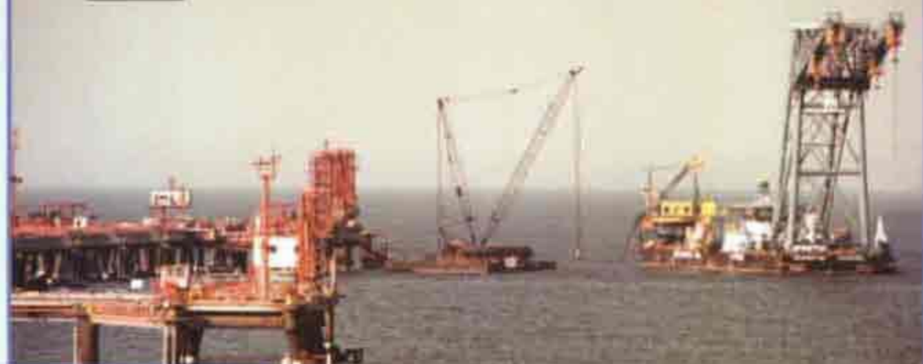
BARGE 68 CON A.H. 11310 PORTATA 300 TON. PER RECUPERO BRACCIO CLYDE M. 30
