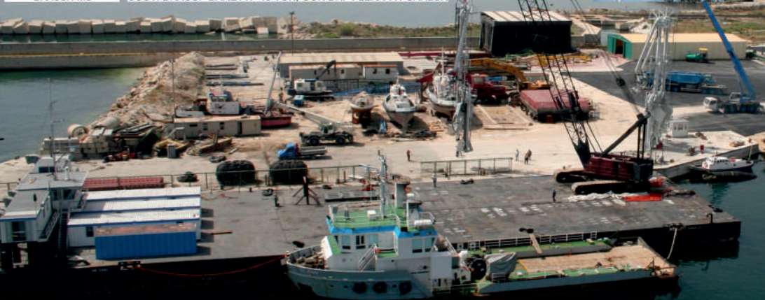
YARD PRIOLO - OFFICINE DI MANUTENZIONE BRACCI "FMC"
