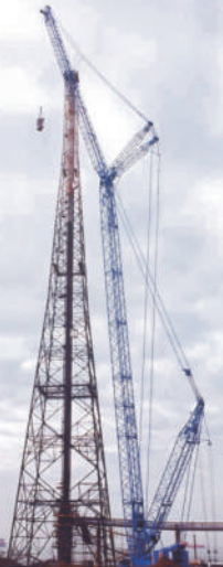
Sostituzione TIP Raff. di Gela - 168 mt di altezza
