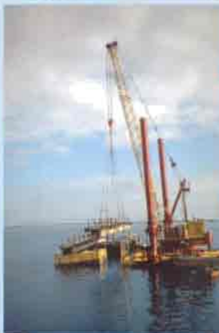
Smontaggio travi in C. A. P. composte, da mt. 25 ciascuna.
