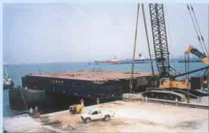
Pontone Comap - M - in fase di imbarco sulla barge sollevato e spinto dal lato Dx dalla gru 450 tons.
