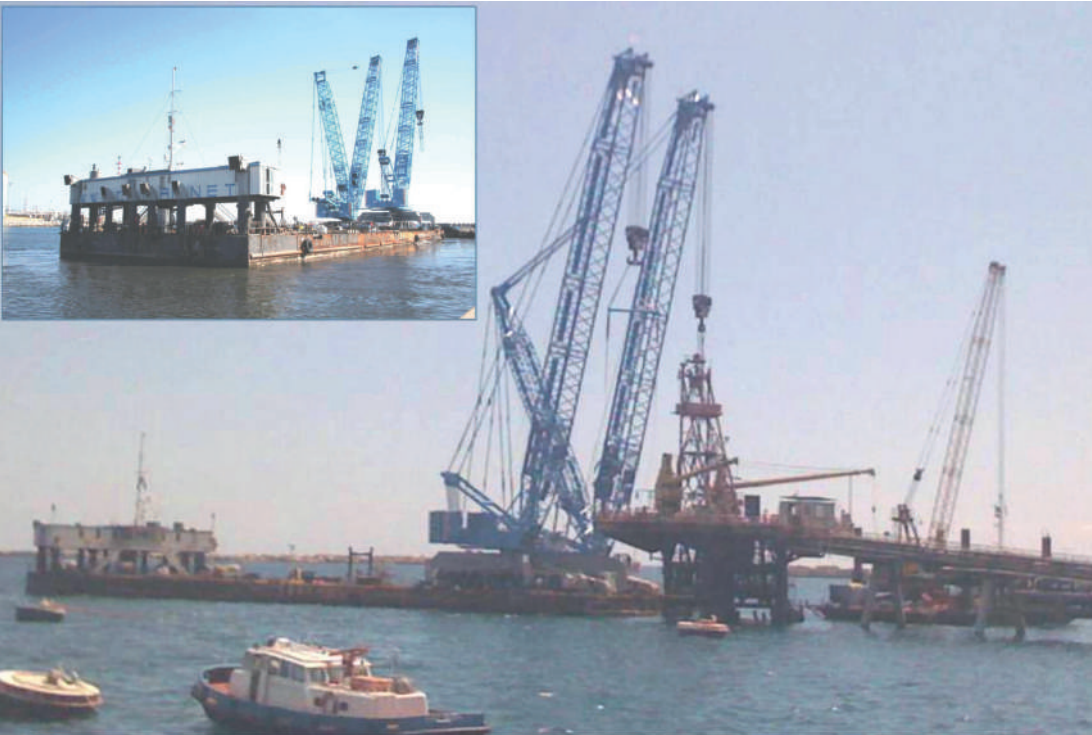
Sollevamento struttura Pontile 27 Raff. ERG Priolo 09-08 - Barge DP0 con Gru Liebherr da 850 T. x 2 RINA 1300 T.
