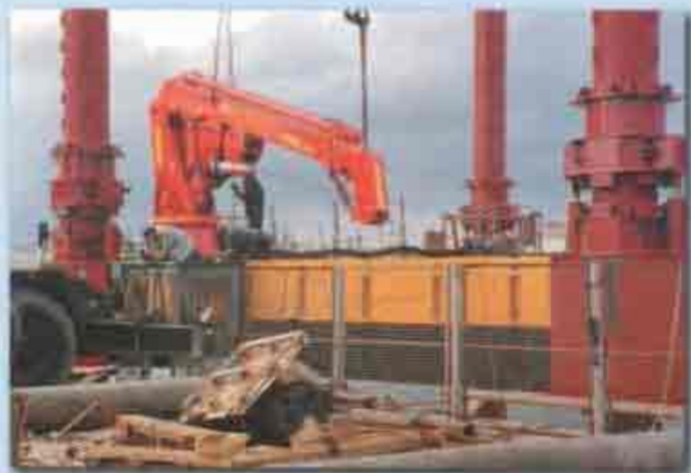
Con gru covis 22 ton. With 22 ton. crane covis
