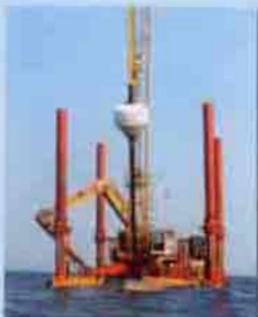
Avanzamento della box di segnalazione nel punto prefissato sul fondo marino
