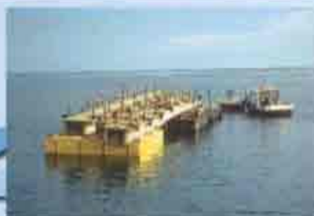
Smontaggio travi in C. A. P. composte, da mt. 25 ciascuna.
