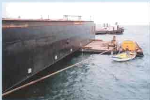
Barge in fase di immersione per lasciare il pontone Comap - M - in galleggiamento
