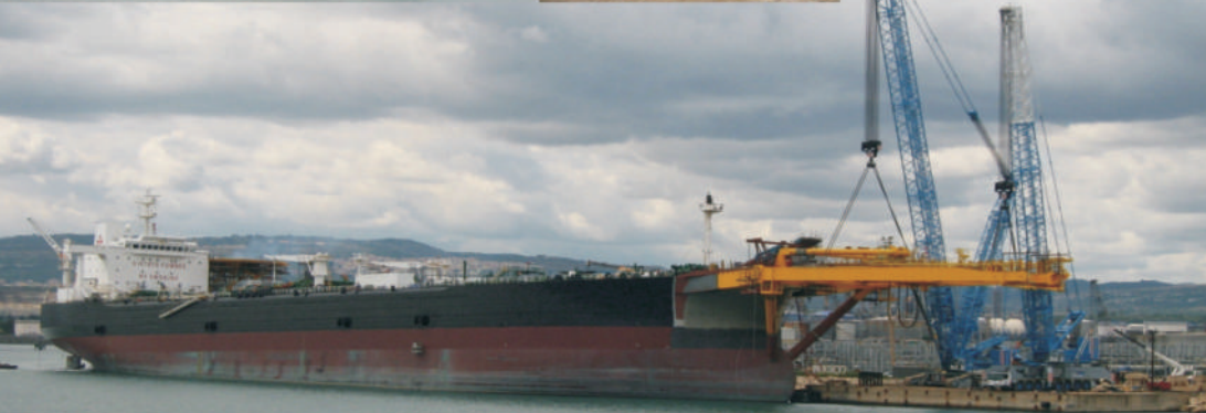
MTG in tandem con LG/LR 1750 dello Yoke (515 t) C. Italooffshore su nave Leonis
