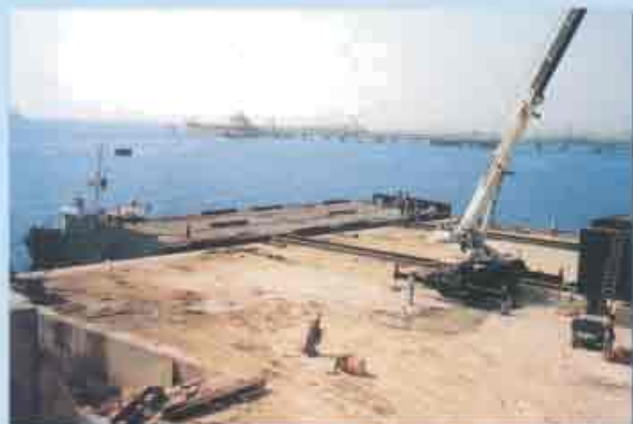
Rimorchiatore e barge in posizione per ricevere il pontone Comap - M -
