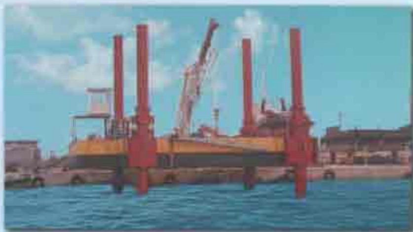
Con gru 90 ton. With 90 ton. crane
