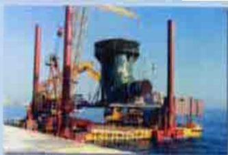
Imbarco della camera di aspirazione
